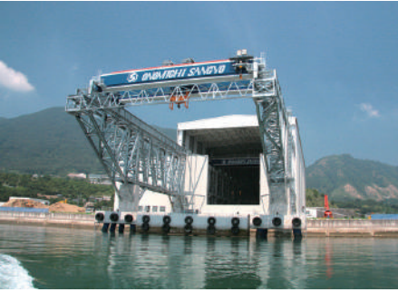
105t+105t/15t 天井クレーン
